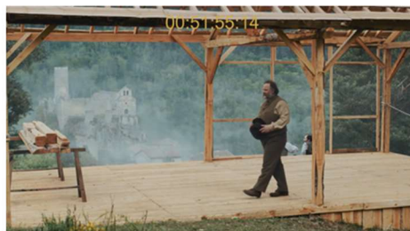
E - l'école est en construction
